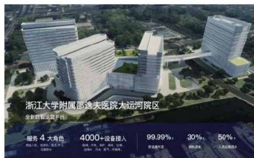
浙江大学附属邵逸夫医院大运河院区
